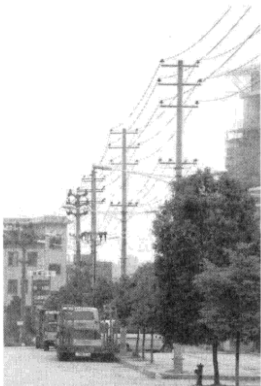
图 1-25 同一档距导线弧垂相同
