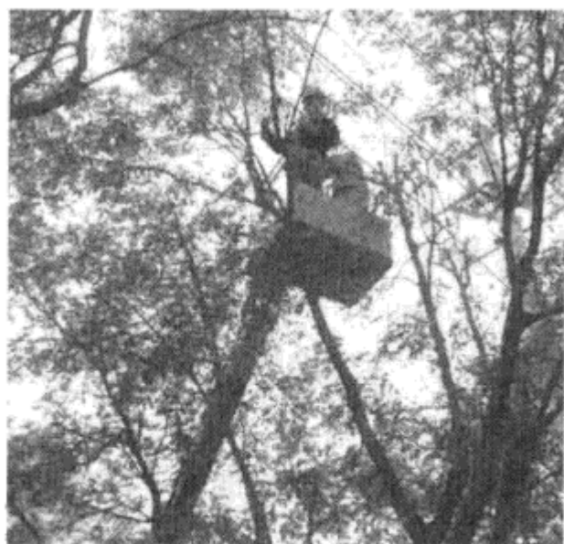
图 1-27 树枝碰触导线
