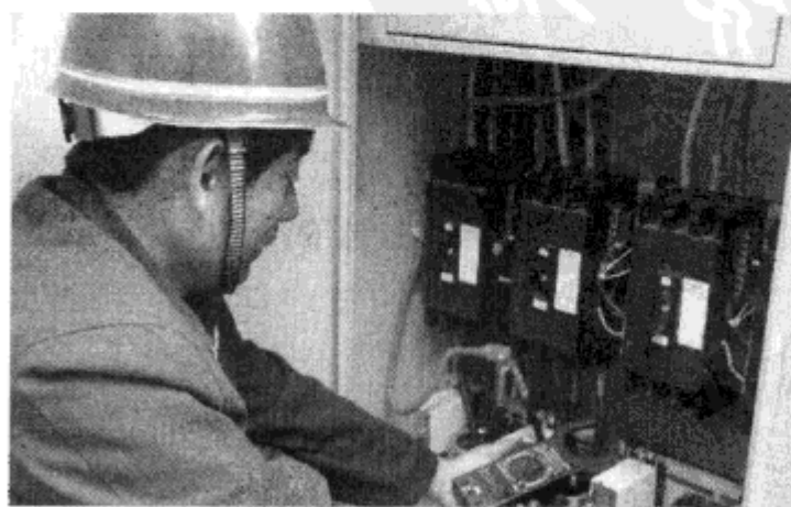
图 1-13 用电压法查找断路故障
