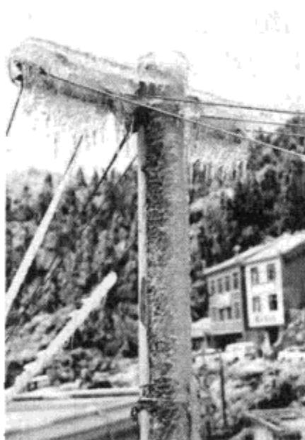
图 1-30 覆冰的电线杆
