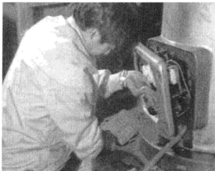
图 5-30 更换电源总开关
