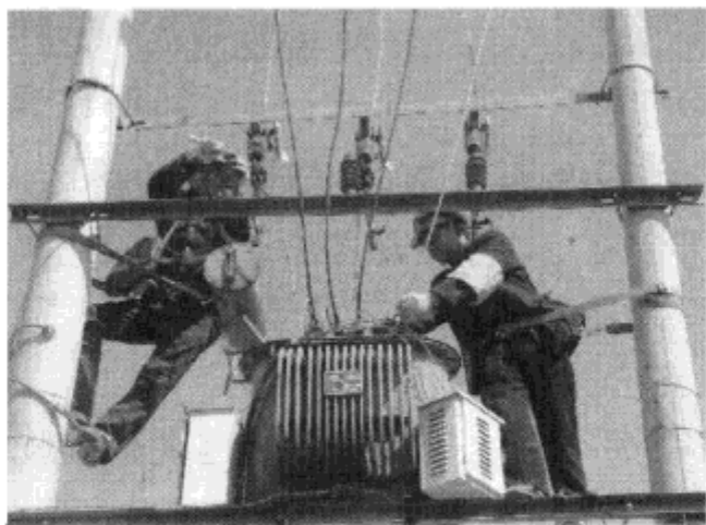
图 5-44 停电检查并清扫变压器
