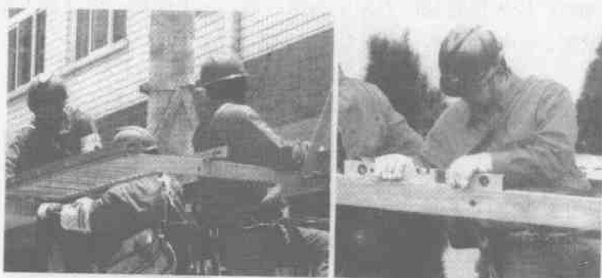
(a) 安装踏脚板
