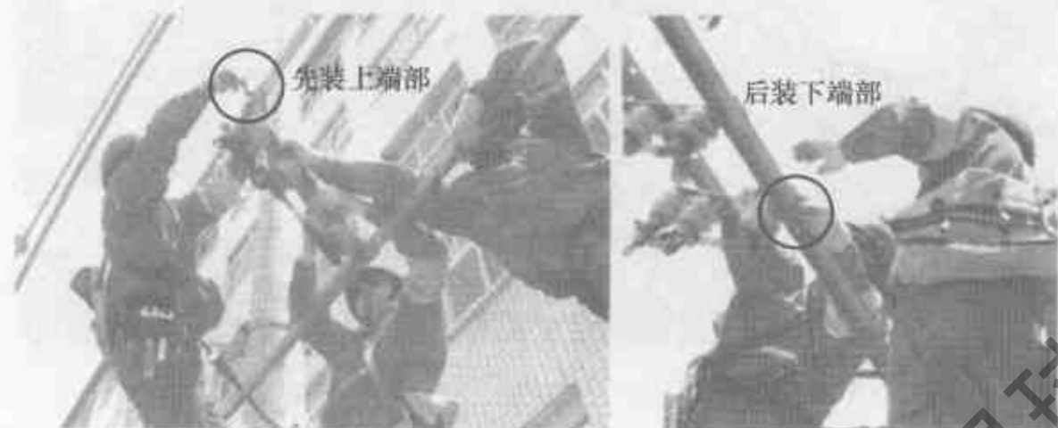
图 6-32 低压刀闸的安装
