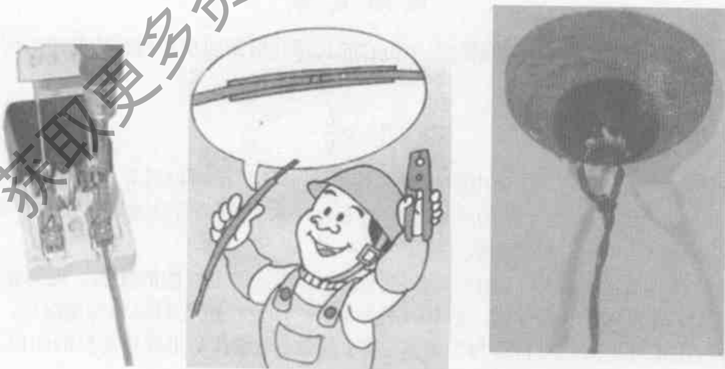
图 1-23 连接导线时要尽量减小接触电阻
