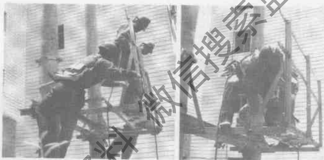
图 6-29 台架靠背的安装
