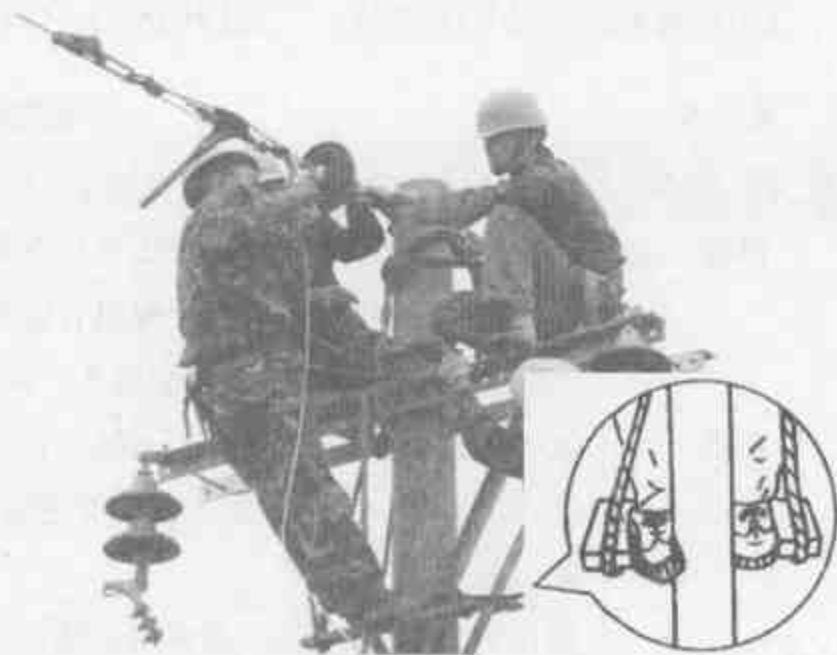
图 9-9 在电杆上作业的安全措施
