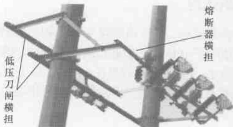
图 6-30 台架上层部件的安装
