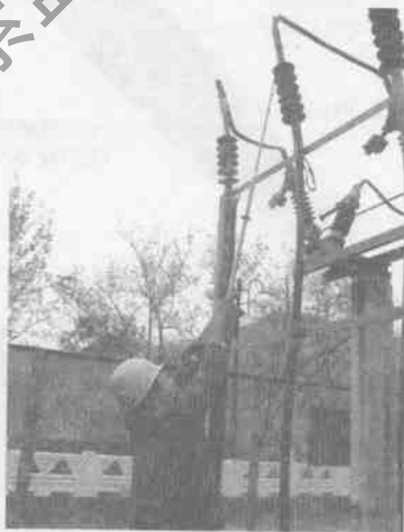
图 7-12 使用高压验电器验电
