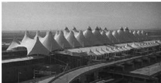
图 5-28 丹佛国际机场航站楼 [121]
