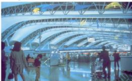
图6-10 大阪关西机场航站楼开口风道 [59]
