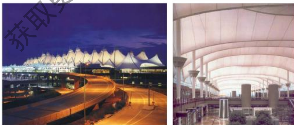
图6-5 丹佛国际机场航站楼 [95]
