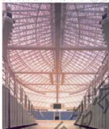
图5-37 广州体育馆室内 [137]
