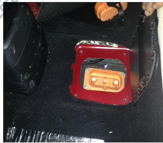
断开维修开关
