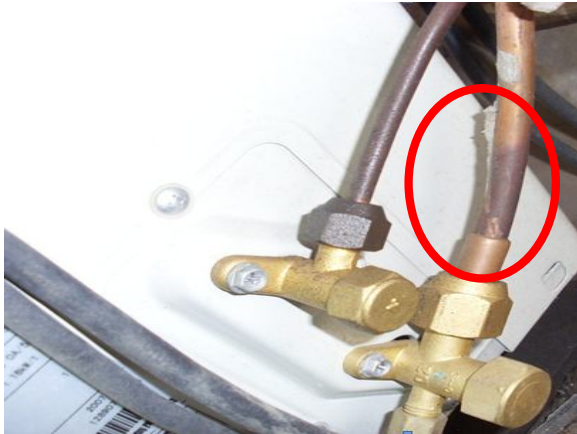
加长连接管偷工减料，影响空调使用效果
