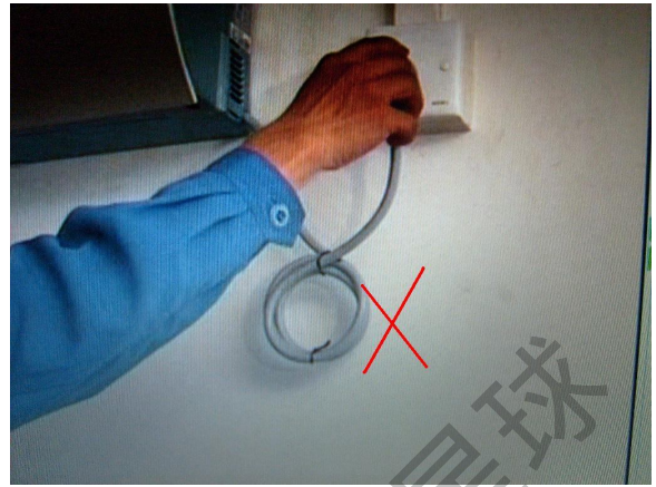
电源线缠绕成小圈，产生强大的涡流发热将烧坏线路，引起火灾
