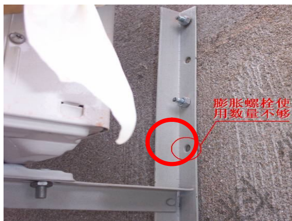
膨胀螺栓数量不够，外机不牢固
