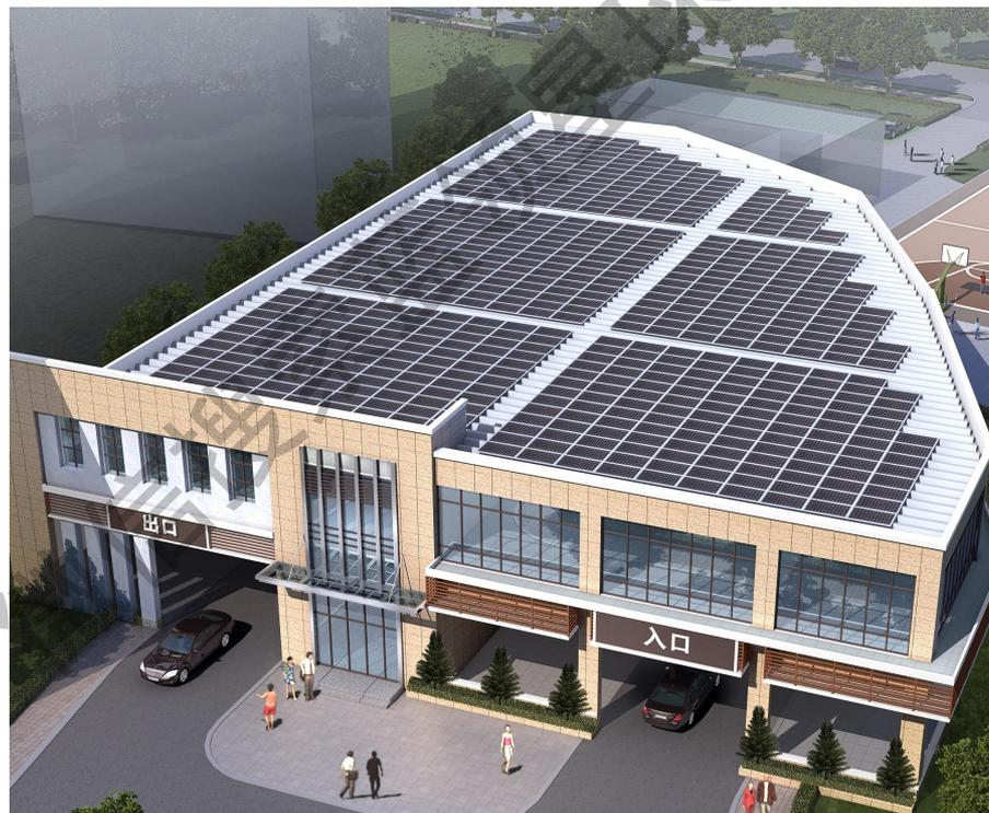
2. 太阳光伏板的布置与屋面板平行，屋顶布置光伏电池板数量为670块，屋顶光伏装机容量约为177.55kw，结合厦门市历年气象资料，预计全年发电量可达到239300KWh。
