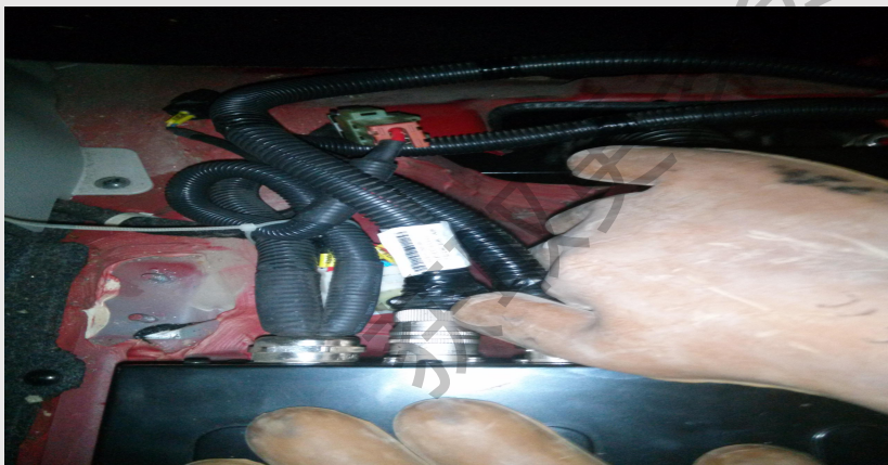
11 拆下动力电池低压电缆线
