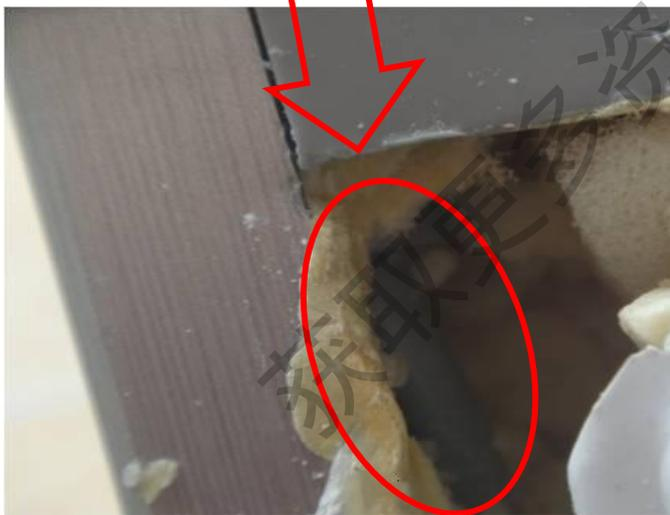
4.使用一字螺丝刀将导线撬出，待露出导线断裂部分即可。
