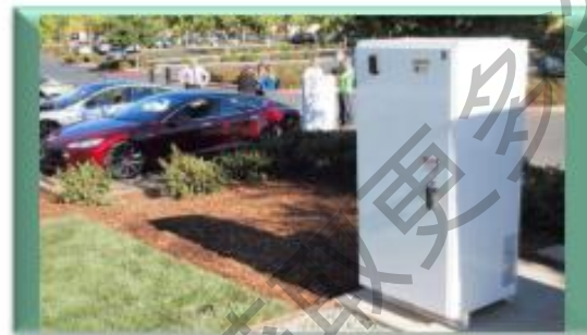
这个充电桩内部有十几个10kw的充电器，由计算机控制。一个120kw的充电桩可以同时为两辆车充电。
