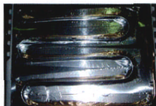
图1 用手工贴覆铝箔的冷藏室蒸发器
