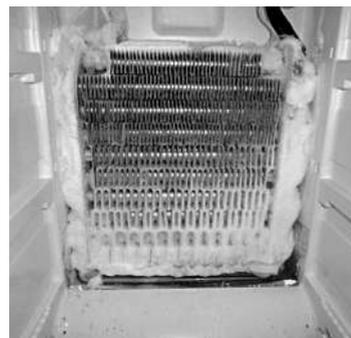
图2 接通加热器前蒸发器上结霜情况
