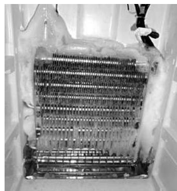
图3 接通加热器后第二次化霜效果
