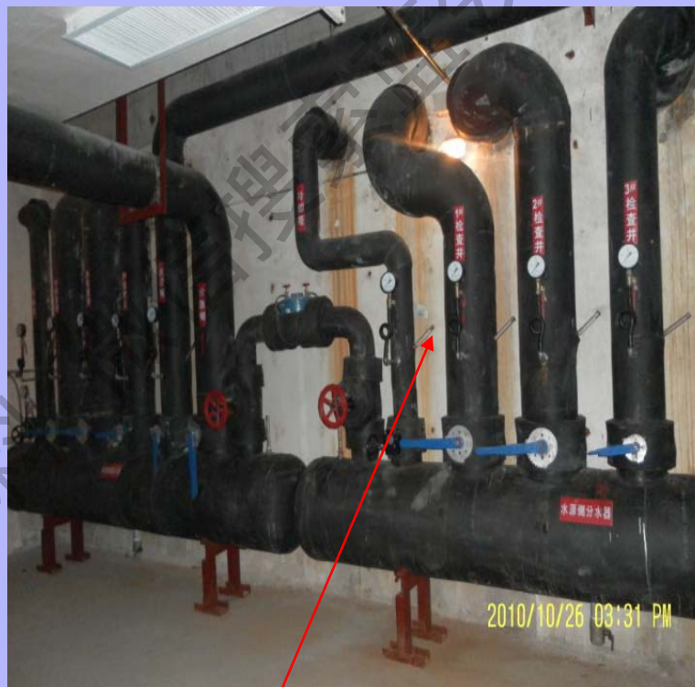
正确（压力表、标识方向、旁通阀）
