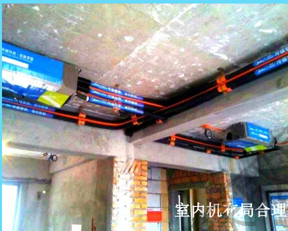
管路安装整齐美观、按要求粘贴管路标识件。
