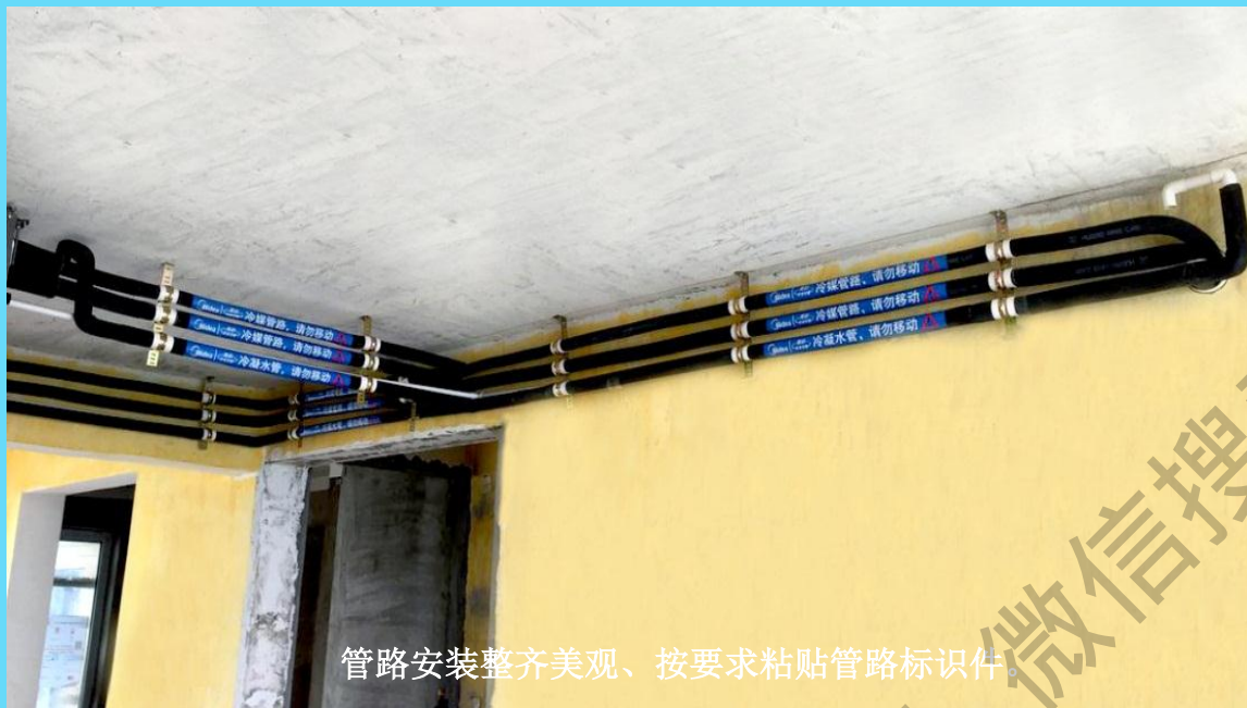
冷媒管与室内机 300mm~500mm 处应安装固定码。
