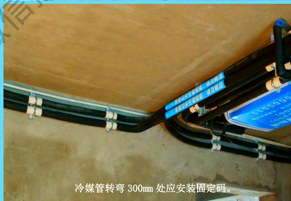
冷媒管、排水管的固定码间距符合要求，安装方式统一美观。
