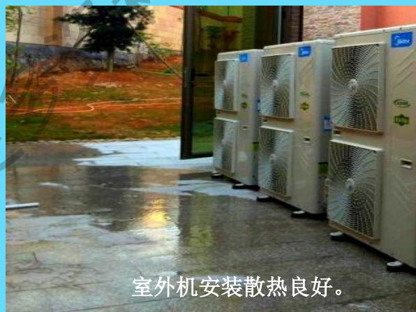
室外机安装于楼盘设计预留位置，散热良好。
