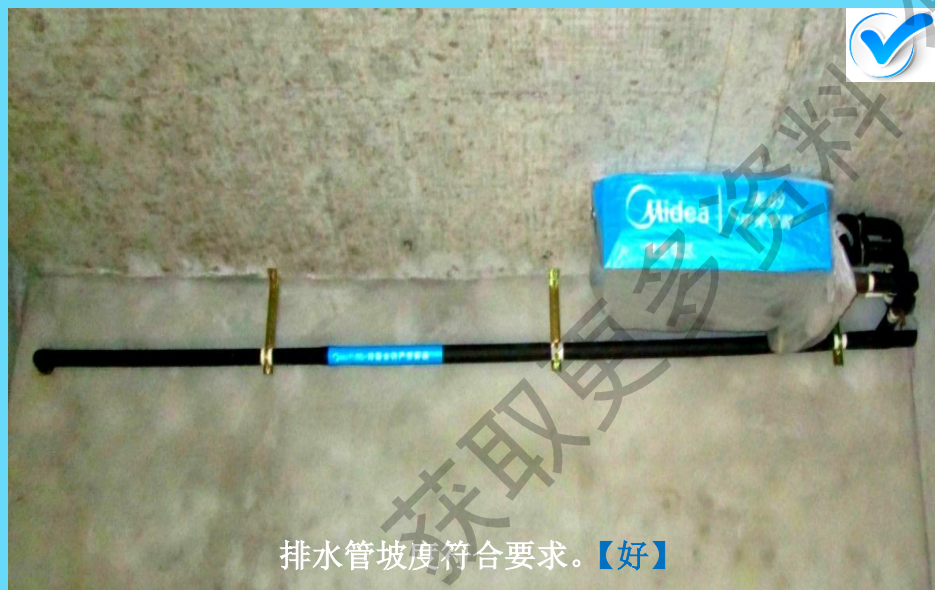
排水管通气口朝下, 安装美观。【好】
