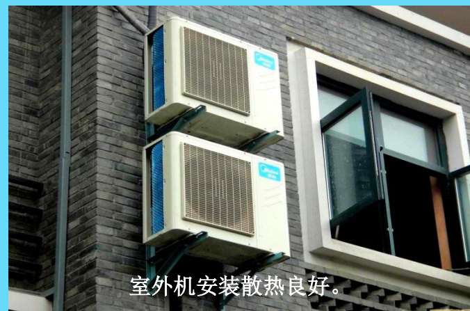
室外机安装散热良好。
