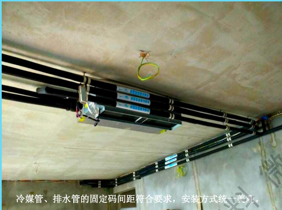
冷媒管、排水管的固定码间距符合要求，安装方式统一美观。
