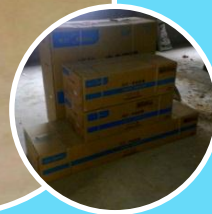
设备及安装材料摆放整齐
