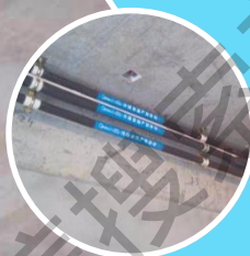
管路固定码间距符合要求
