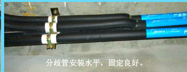
冷媒管转弯 300mm 处应安装固定码。
