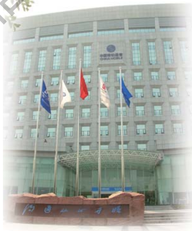
成都中国移动通信办公大楼
