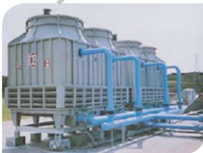
图3-1-1 逆流式冷却塔
