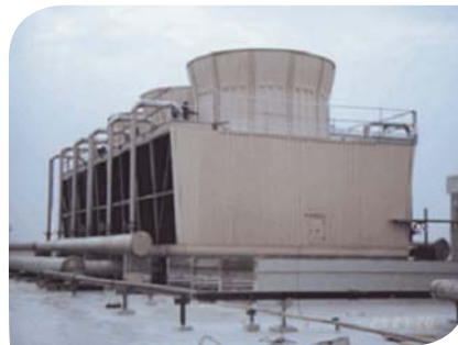
图3-1-2 横流式冷却塔
