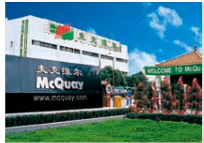
中国深圳平湖 麦克维尔洁净空调亚洲生产基地
