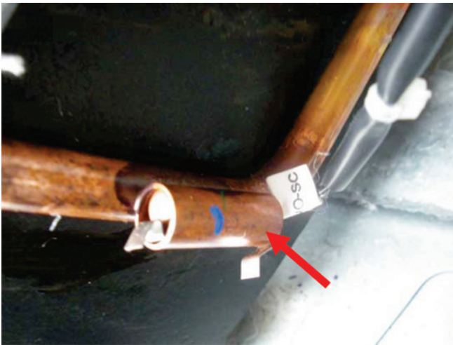
拆下圆顶下温度传感器
