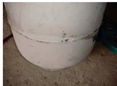
图 - 7 (利用图中所示的钢瓶替代室外机压缩机蓄冷器)
