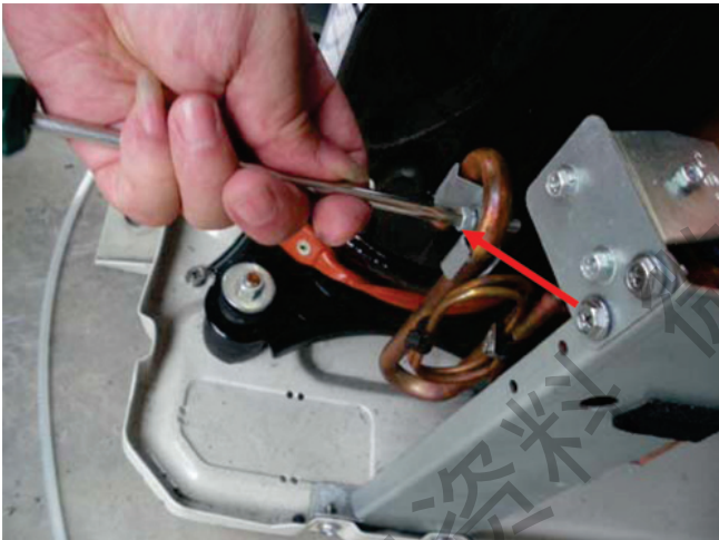
装上压缩机与回油管之间的固定螺丝
