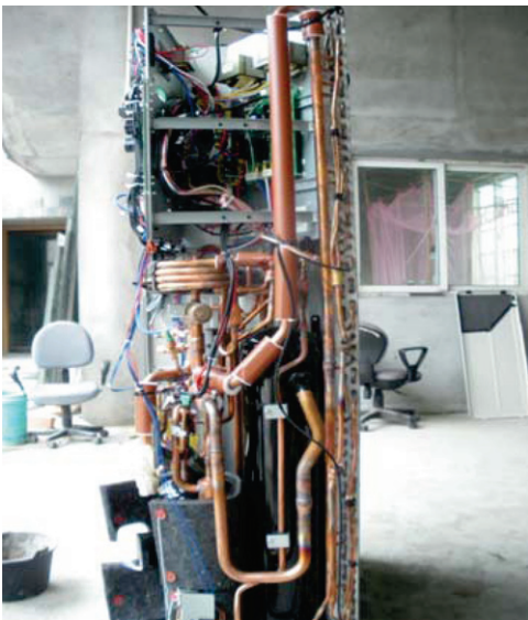
拆除室外机后挡板
