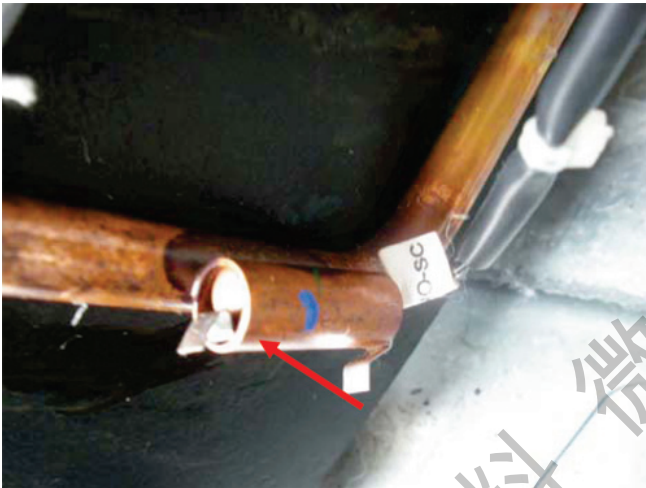
装上圆顶下温度传感器
