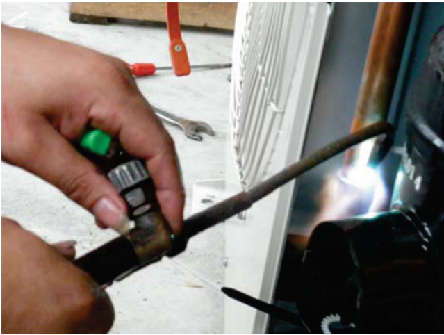
拆卸回气管
