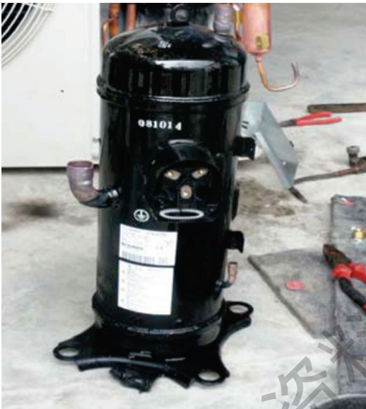
取出的压缩机放置在空地处
