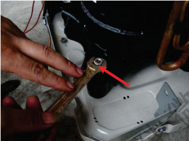
拆卸压缩机底角固定螺丝
