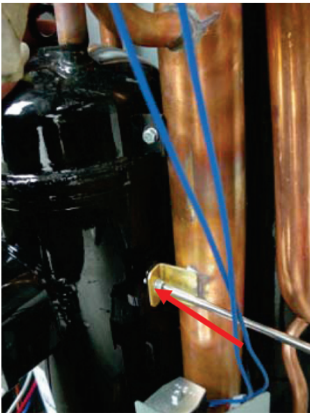
装配压缩机与贮液器回液管之间的固定螺丝
