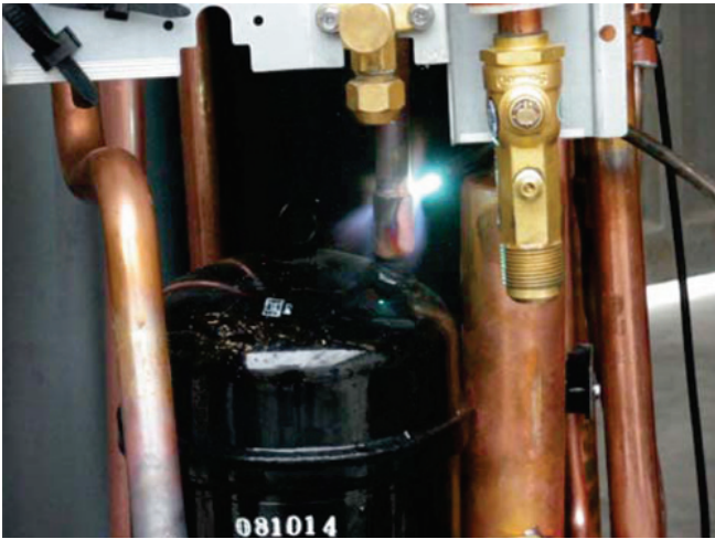
焊接压缩机排气管
