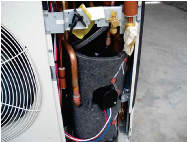
装配压缩机身外的隔音材料
