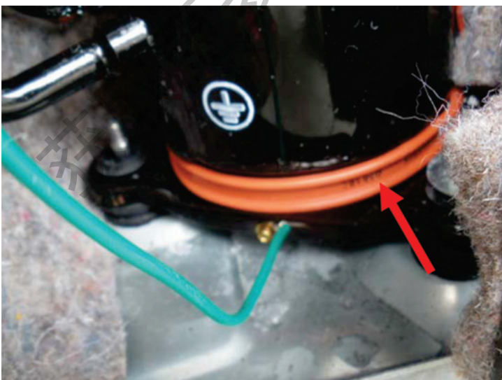
拆除压缩机底部曲轴箱加热器
