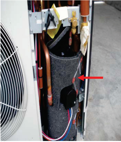
去除压缩机的隔音材料
