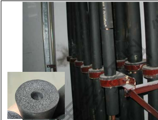
保温厚度符合要求，材料厚实
