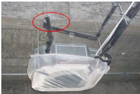
提升段需要吊杆固定
