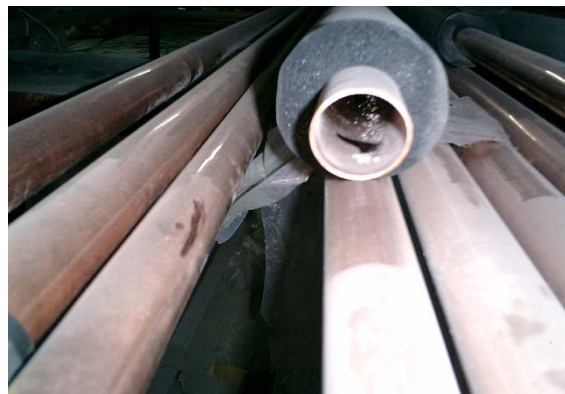
冷媒铜管没有封口、有杂质
