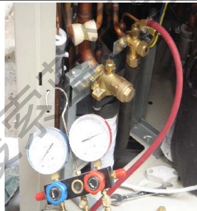
单侧加压，易造成室内机膨胀阀阀体损坏
