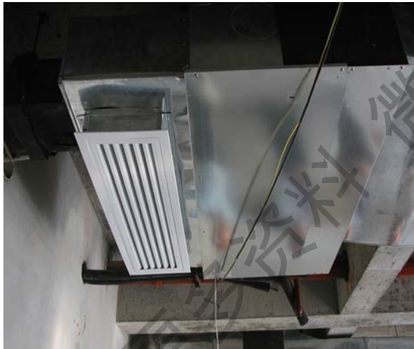
回风风口设置合理，加装过滤网
