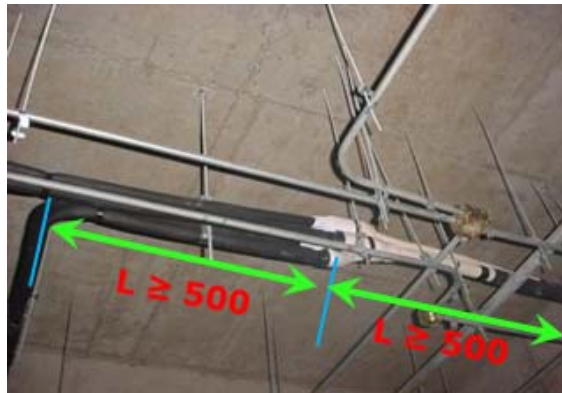
分支管前后水平段符合要求
