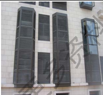
机器安装在相对密闭的空间、外部栅格过密，影响散热，易造成机器保护及过负荷运转
