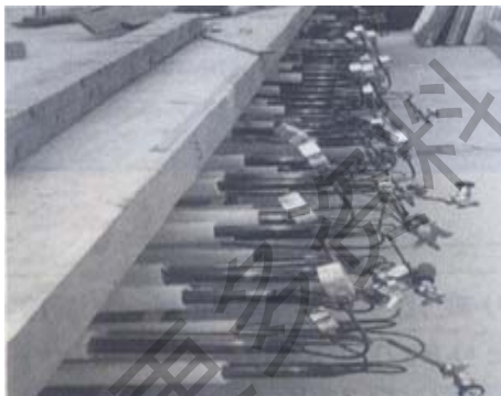
从气液两侧同时加压，避免室内机膨胀阀阀体损坏
