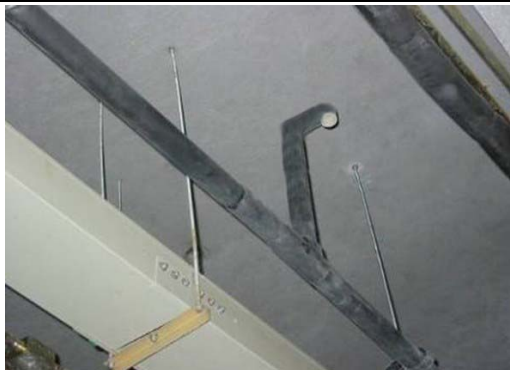
通气口设置合理，管口朝下
