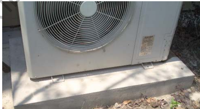
未采用减震垫和螺丝固定，易产生振动及噪音
