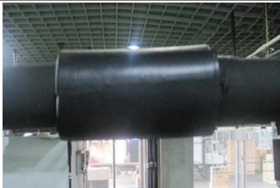
保温断面使用胶水及胶带连接
