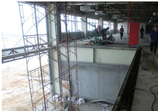
机器吊装过高，热风难以吹下来
