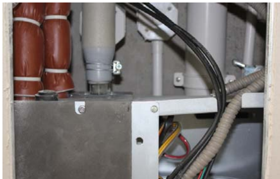
室内机电源线使用护套软管接入到室内机
