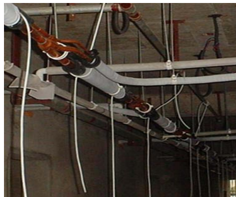
信号线采用星型连接，产生信号干扰
