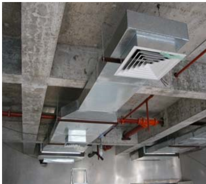
风管适当变径可以确保送风风速
