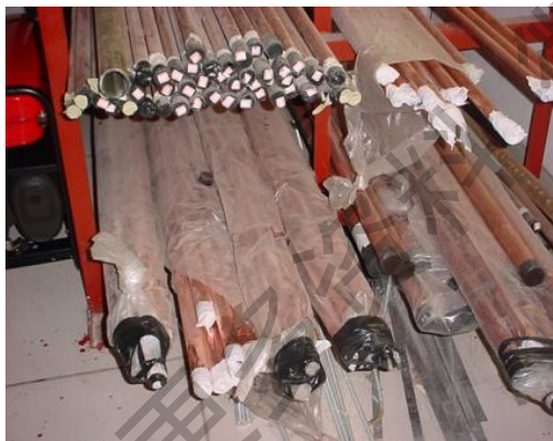
冷媒铜管封口保护
