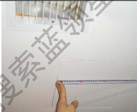
检修口尺寸过小，只有 300 \times 300\text{mm} ，建议 450 \times 450\text{mm}
