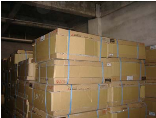
室内机堆码在限定层数内，室内机不易变形
