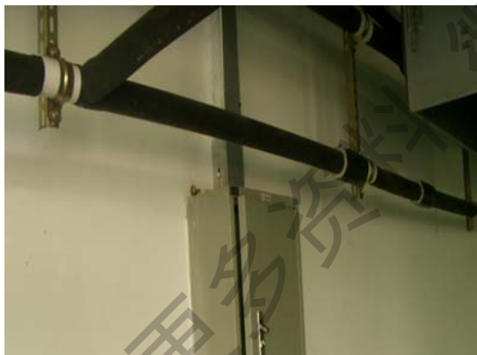
室内铜管保温无需使用胶带包扎，室外为美观应包扎
