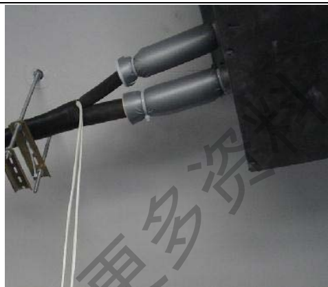
信号线采用手拉手的串联方式进行连接
