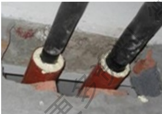
铜管穿墙需要套管保护
