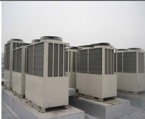
基础平台厚实、散热及维修空间足够
