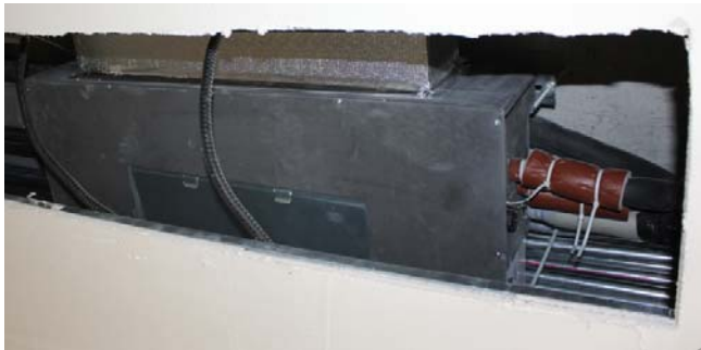
室内机铜管及排水管处应使用机器附带的保温包扎
