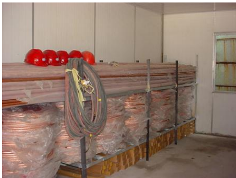
冷媒铜管高于地面放置，摆放整齐
