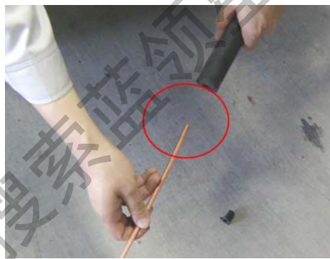
铜管穿保温时没有封口，杂物容易进入铜管
