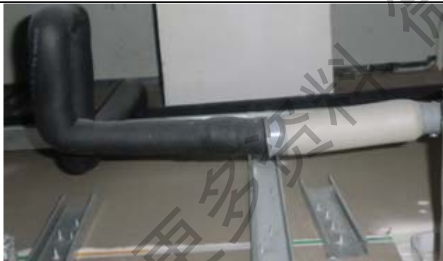
排水管连接处使用附带的保温包扎
