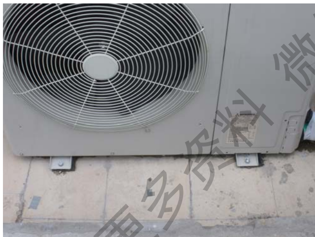
采用减震垫并用螺丝固定
