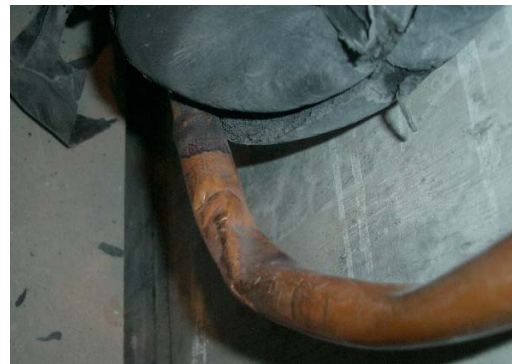
使用手工弯管，铜管极易变形
