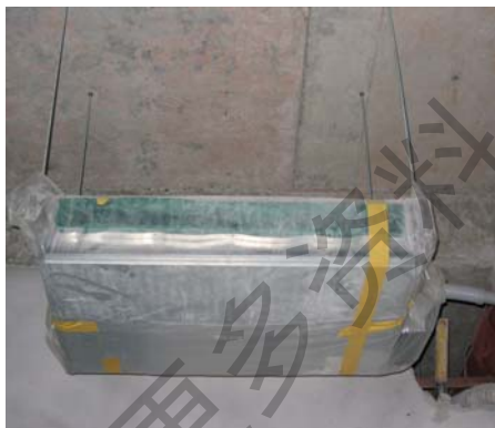
机器吊装时应保持机器水平并采取保护措施
