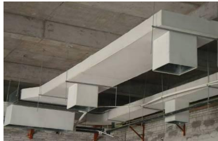
送、回风管安装规范，送回风顺畅 （正确）
