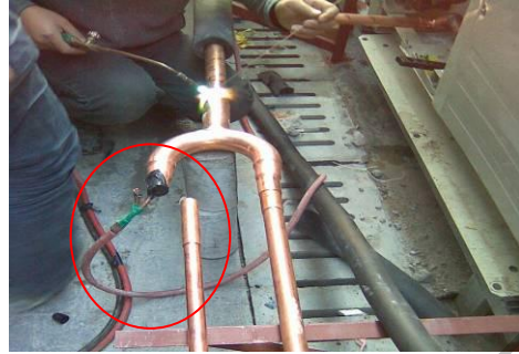
充氮气保护，避免产生氧化皮（正确）
