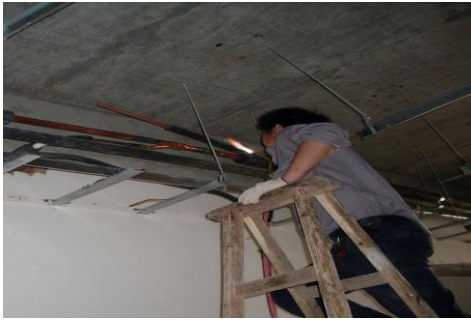
铜管焊接时没有充氮气保护（错误）
