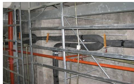
室内分歧管使用 U 型分歧管（正确）
