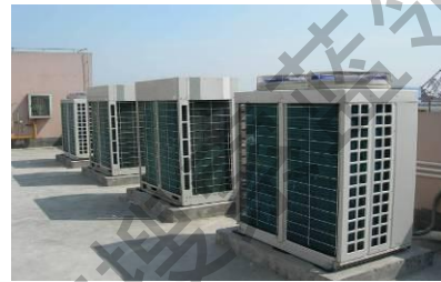
外机散热效果好（正确）
