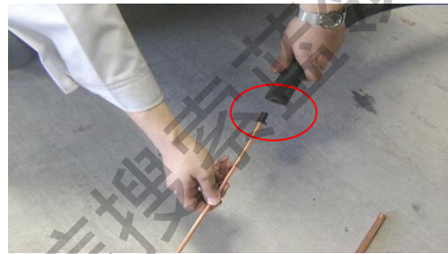
铜管封口后，再套保温管（正确）
