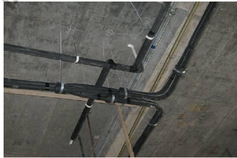
吊杆间距符合要求（正确） （间距在 1~1.5m）
