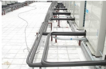
室外机分歧管安装规范（正确）
