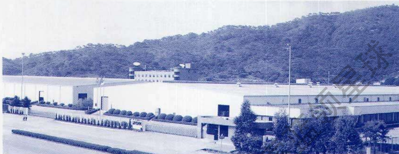
约克广州空调冷冻设备有限公司
