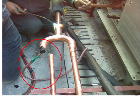
充氮气保护，避免产生氧化皮（正确）
