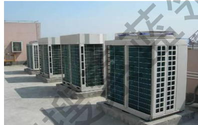
外机散热效果好（正确）
