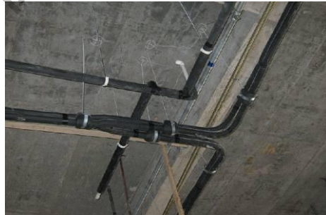
吊杆间距符合要求（正确） （间距在 1~1.5m）
