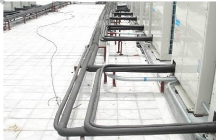
室外机分歧管安装规范（正确）
