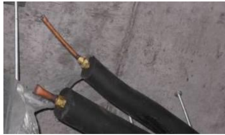
管路施工完成后要对管路进行封口处理，焊封或是用胶布封口（好）
