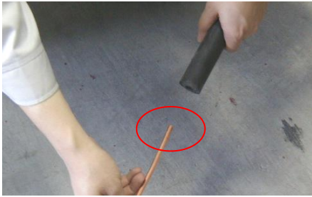
铜管套保温管的时候没有封口，导致杂物入管内（错误）
