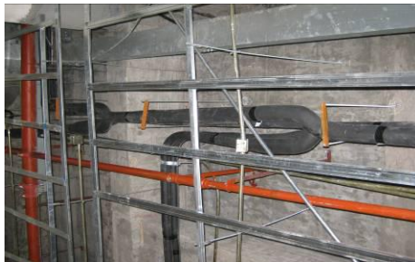
室内分歧管使用 U 型分歧管（正确）
