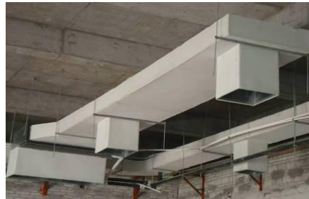
送、回风管安装规范，送回风顺畅 （正确）
