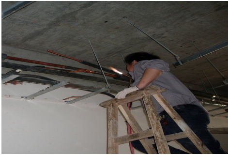
铜管焊接时没有充氮气保护（错误）
