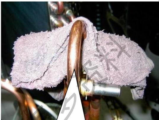
焊接时要用湿布包住四通阀的主阀体和先导阀，防止烧坏四通阀
