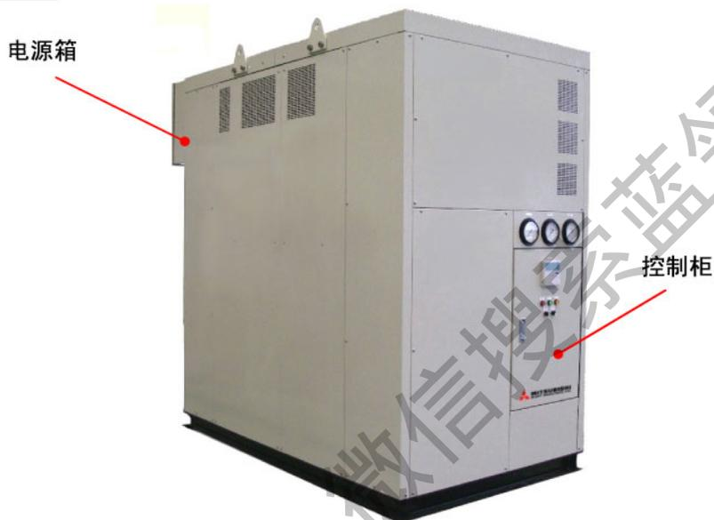
图 9-2 所示为控制柜的外形。控制柜内部带有用于控制的微电脑电路板，用于进行热泵的温度调节等控制。
