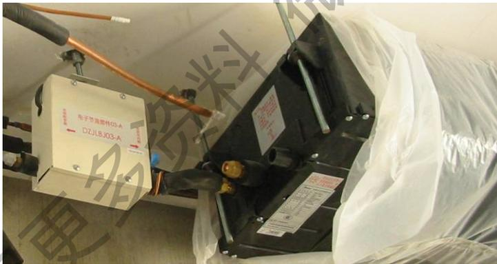
3.4. 管道焊接时要充氮气进行保护，管路安装焊接好后进行吹污。
