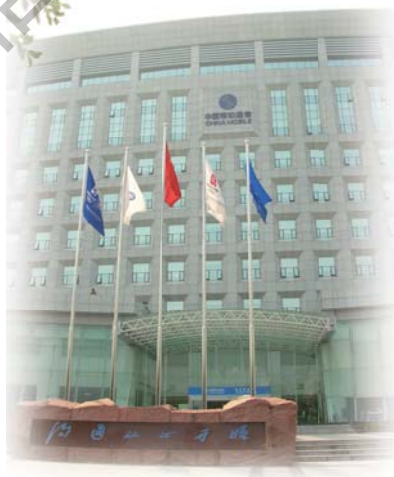
成都中国移动通信办公大楼
