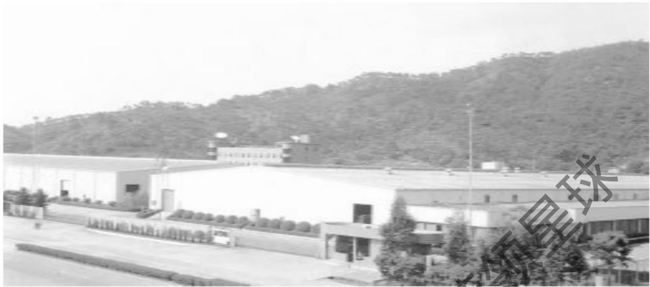
约克广州空调冷冻设备有限公司
