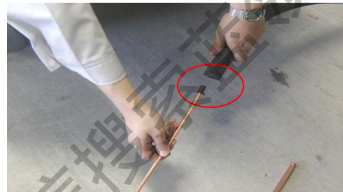
铜管封口后，再套保温管（正确）
