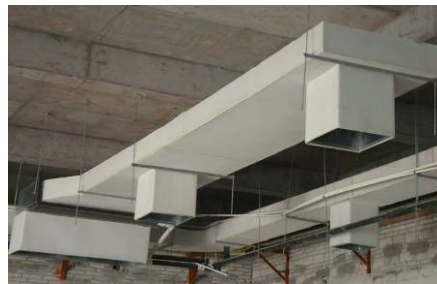
送、回风管安装规范，送回风顺畅 （正确）
