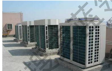
外机散热效果好（正确）
