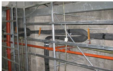
室内分歧管使用 U 型分歧管（正确）
