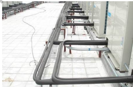
室外机分歧管安装规范（正确）
