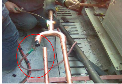
充氮气保护，避免产生氧化皮（正确）
