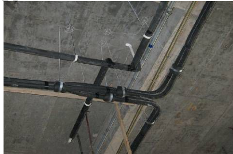
吊杆间距符合要求（正确） （间距在 1~1.5m）
