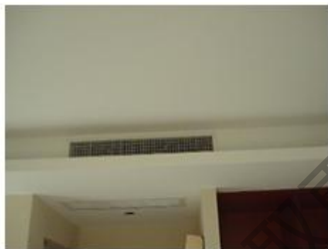
图 1：内机出风口、回风口布置在灯带上方，影响机组的使用效果
