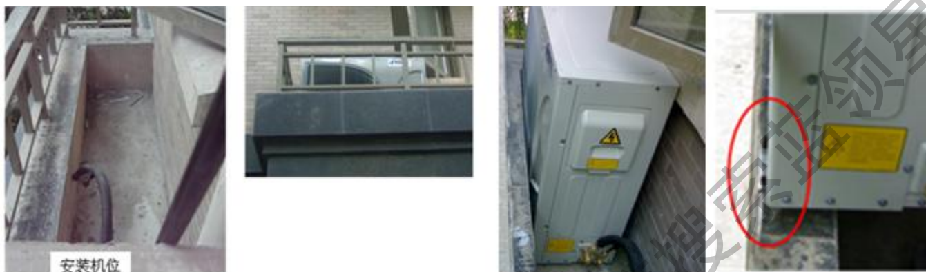
图 1-图 3：外机出风口阻挡约 1/2，同时回风间距太小，影响机组散热效果；
