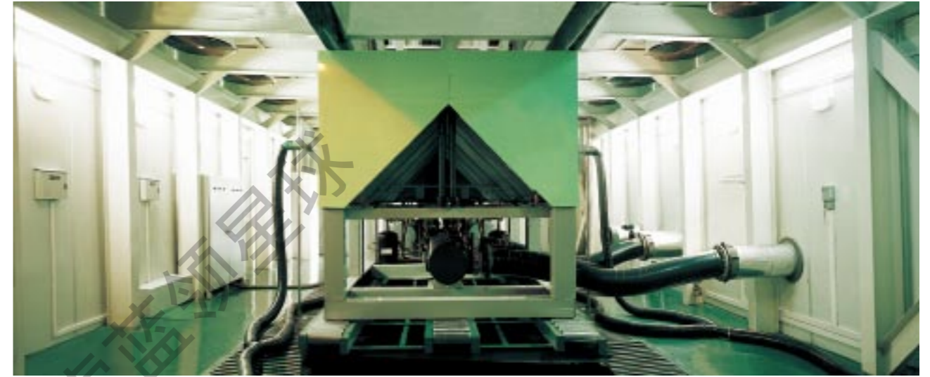
风冷热泵测试室（深圳），测试能力达1600kW
