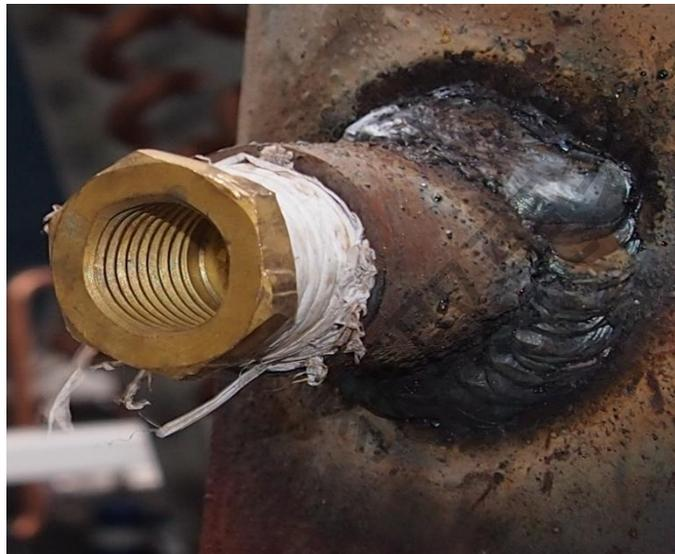
系统进出水温度探头盲管安装组件
