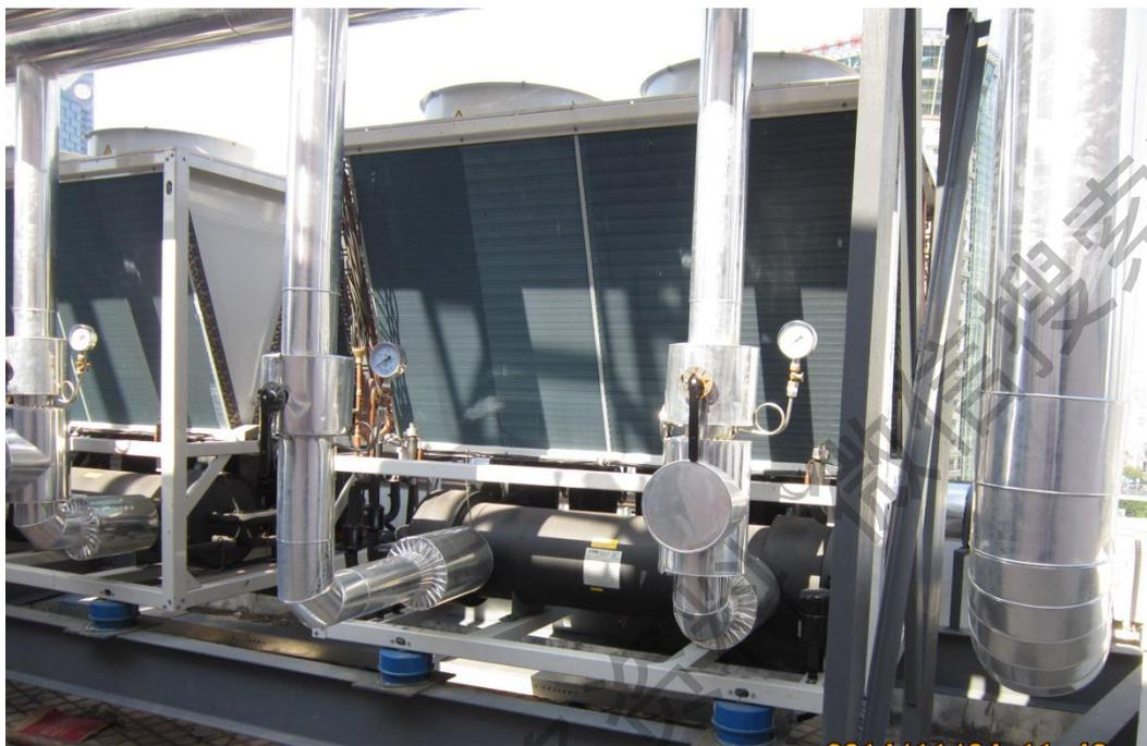
YCAE100\130机组出水管为法兰连接，机组出厂不带主水管，系统主水管路为现场制作。
