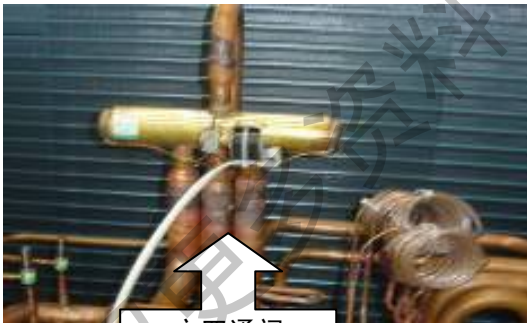
主四通阀 (制冷制热切换用)
