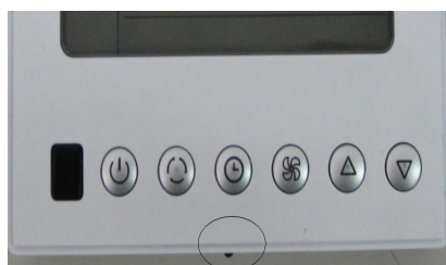
图 3 感温头露出面板允许在 1mm 以内。
