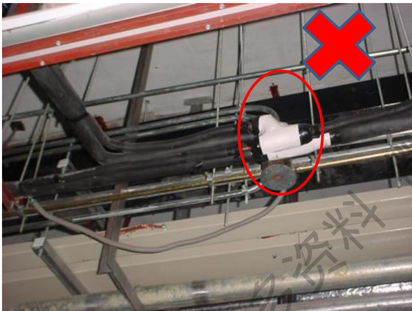
分歧管横管部分必须水平安装
