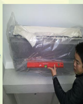
水平测试、螺 母固定、封装
