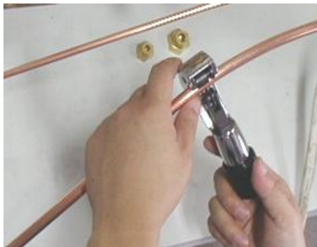
1. 用割刀切断配管
