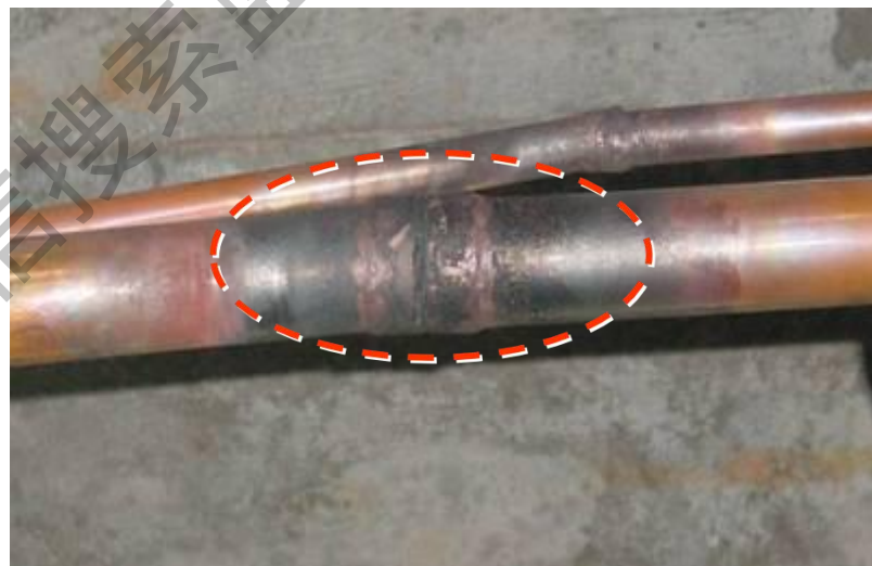
同管径胀管连接（胀管）
