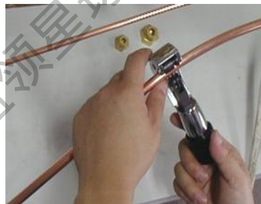
用割刀切断配管
