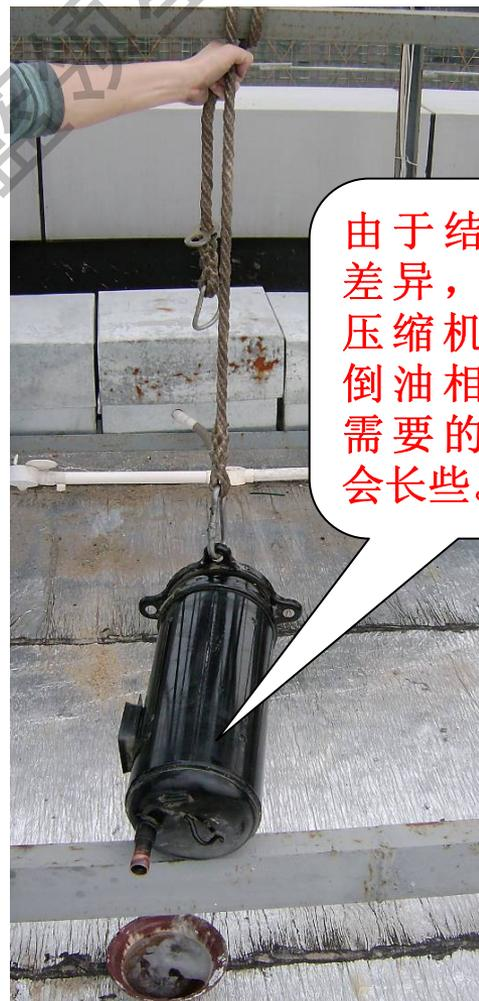
由于结构上的差异，日立的压缩机比谷轮倒油相对困难需要的时间也会长些。
