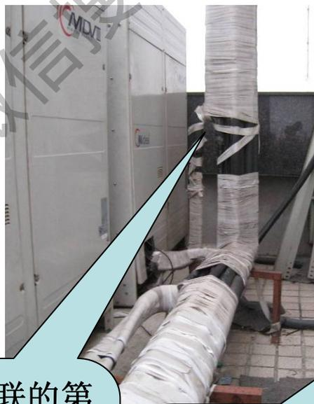
外机并联的第一个分歧管被树着安装，造成主机却冷媒、缺油。
