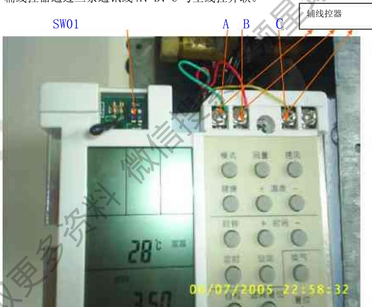
主线控与辅控的区别：辅控制器仅可进行开关机、模式、风量、设定温度、摆风功能设定。
