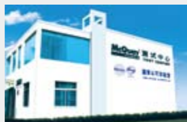
麦克维尔中国深圳工厂测试中心
