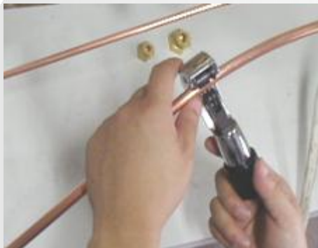
1. 用割刀切断配管
