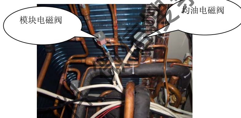
图 21：模块电磁阀位置示意图
