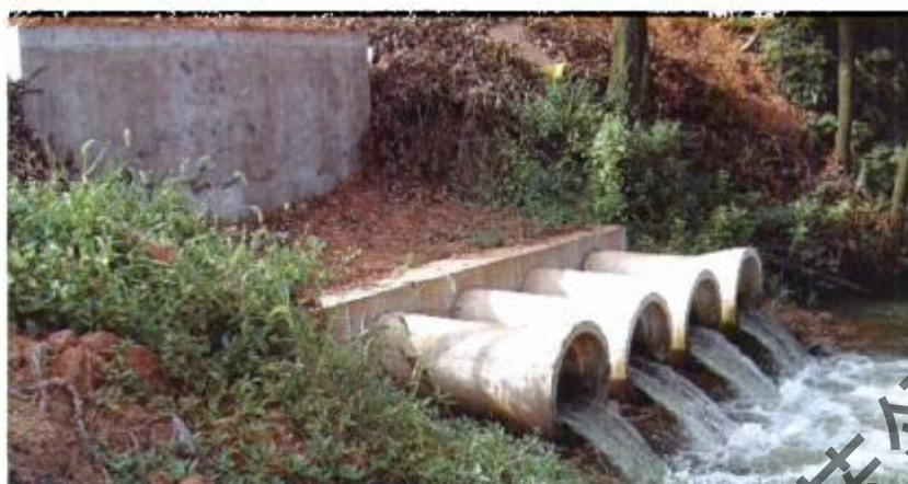
图2.5 开式地表水源热泵系统的排水口
