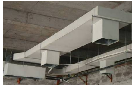
送、回风管安装规范，送回风顺畅 （正确）
