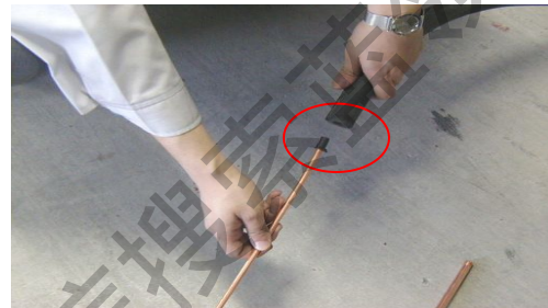
铜管封口后，再套保温管（正确）
