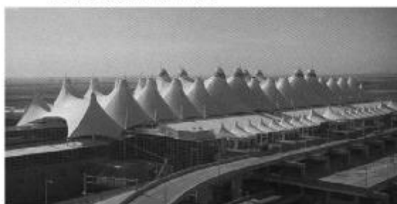
图 5-28 丹佛国际机场航站楼 [191]
