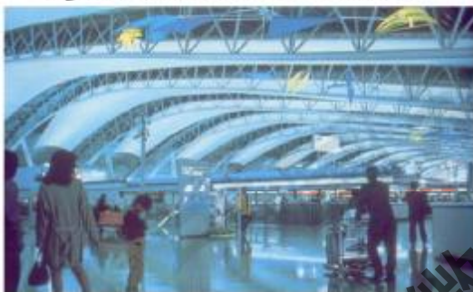
图6-10 大阪关西机场航站楼开口风道 [61]
