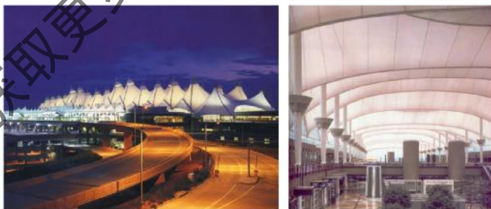
图6-5 丹佛国际机场航站楼 [95]
