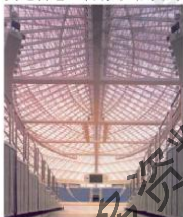
图5-37 广州体育馆室内 [137]
