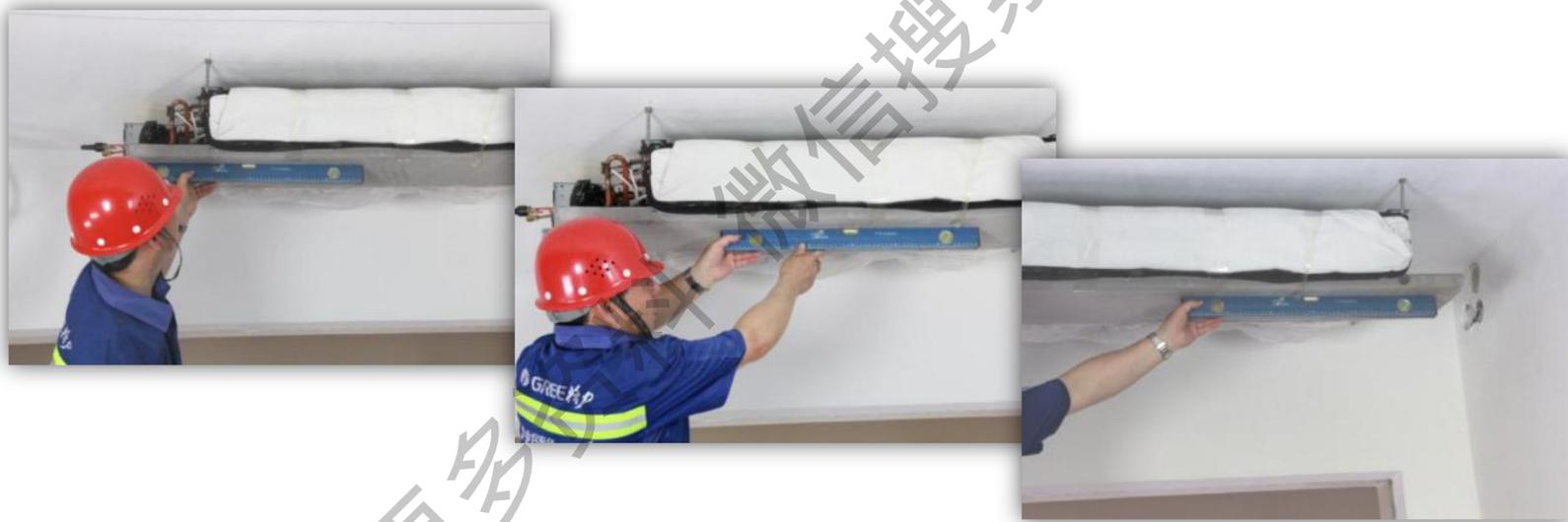
**特别提醒：**保证室内机水平，既可以减小由于电机运转产生的噪音，也可以避免冷凝水从接水盘外溢。
