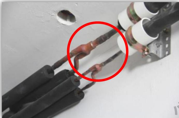
**特别提醒：**焊接前直管段先穿好保温棉，在确认系统无漏点后，再对连接处作保温包扎。
