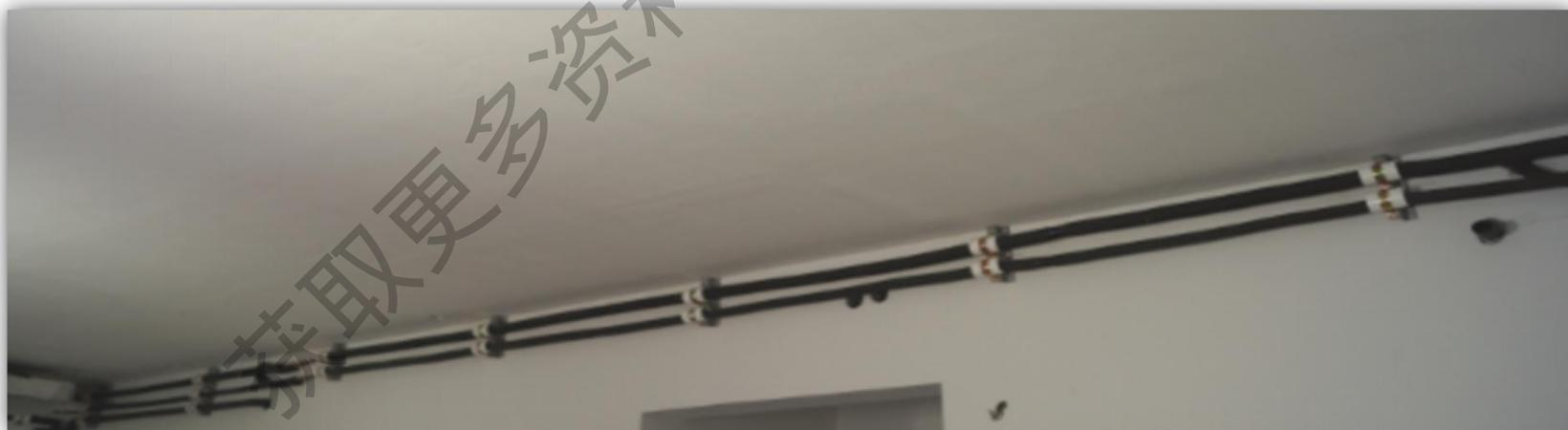
3. 室内、外机接口处和冷媒管焊接处要在气密实验后再进行保温：
