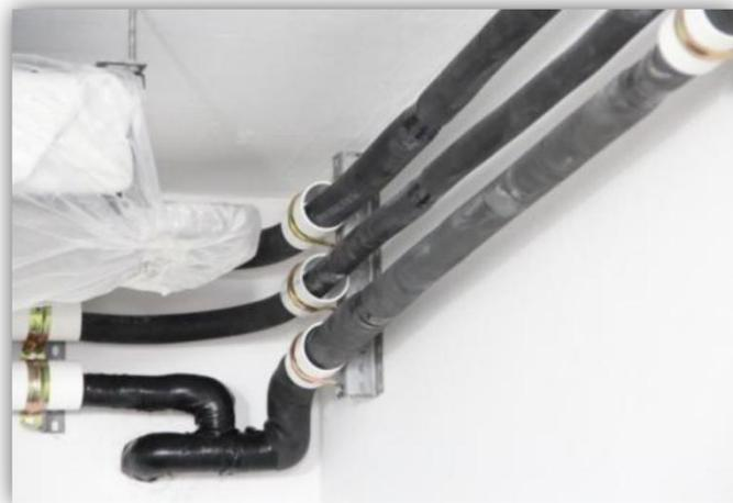
排水管与室内机排水管连接时，必须用管箍固定，不得用胶水粘贴，以保证维修方便，如图所示；
