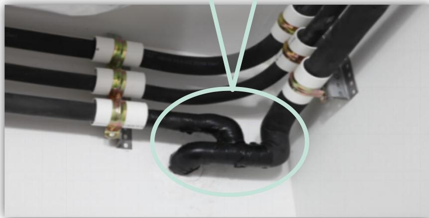
5. **通气孔的设置**: 排水管最高点应设通气孔, 以保证冷凝水顺利排出, 排气口必须朝下, 以免污物进入管道内。
