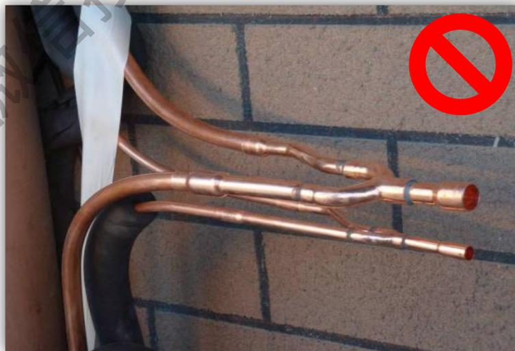
**特别提醒：**分歧管支管方向必须一致，不然会导致冷媒分配不均影响设备制冷制热效果。
