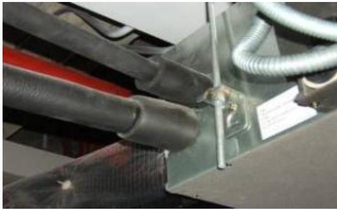
铜管套保温时应将管口封严，以防灰尘水分进入。
