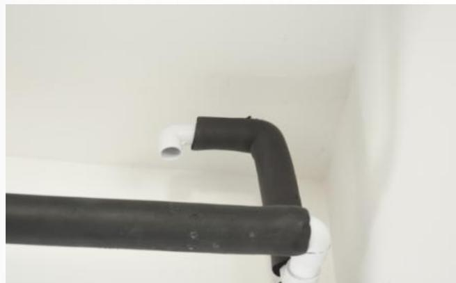
吊架间距：通常横管0.8m-1m，立管1.5m-2.0m，每支立管不得少于两个，横管间距过大会产生挠曲，而产生气阻。形成气袋后，无论怎么排水都只能压缩气袋而无法排水，引起排水异常。
