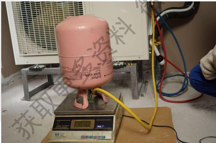
现场连接管路部分应追加充注制冷剂，通过**管径**和**长度**确定追加冷媒量。
