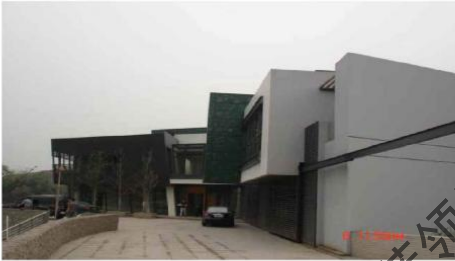
图 6.1 实施地源热泵工程的建筑外观图
