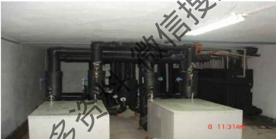
图 6.2 地源热泵工程的机房设备布置图
