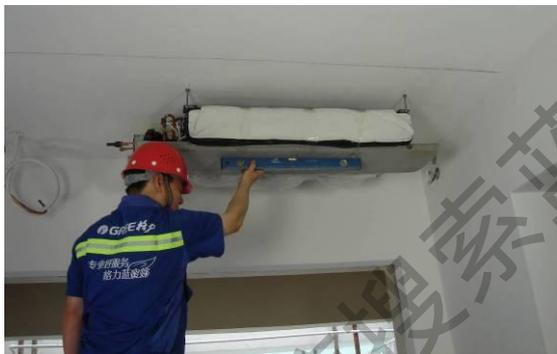
2.3.6. 室内机吊装后要防尘、防杂物，应对室内机进行保护。机组的电器盒、进风口、出风口以及接水盘都应做好防护措施。
