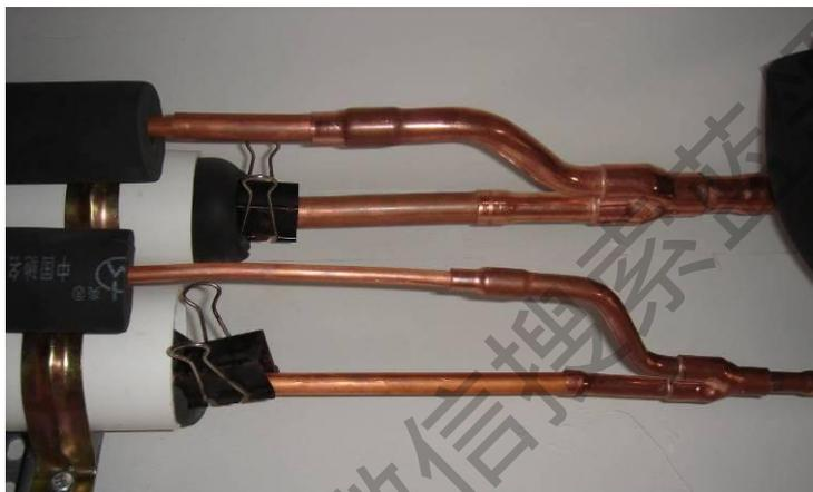
2) 在管路系统强度与严密性检验合格后, 对没有套保温管的裸露铜管部分再进行保温修补。
