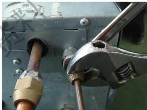
3) 最后使用合适大小的力打紧螺母，注意卡紧管接头的固定开口扳手必须定位好，不能有旋转移动，只能通过旋转卡紧接管螺母的
