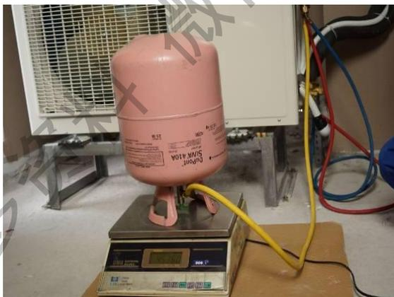
5) 稍微拧开制冷剂罐阀门，再拧松连接软管，排除软管及歧管中的空气，再连接好软管。
