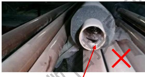
未封口灰尘进入，后期很难清洗干净，若残留在系统内会堵塞过滤器，影响压缩机的回油导致压缩机烧毁。
