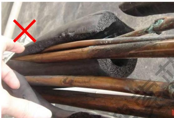
3) 保温管连接处必须涂胶水进行连接, 接口处剪齐平整, 无间隙, 禁止将两端保温管拉伸后再涂胶连接。
