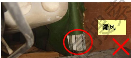
7.1.2. 侧送风的应选择宽度大于30mm的导风叶片风口，否则制热时热风无法送到房间下方，导致空调效果差；
