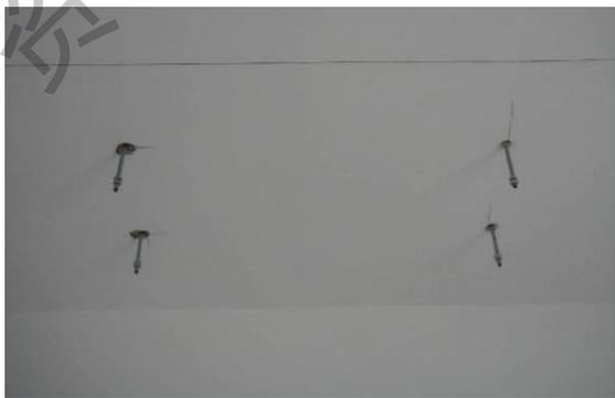
2.3.5. 室内机必须吊装水平，用水平尺检验机组是否吊装水平，室内机可以向排水管侧以3%的坡度倾斜安装，以利于排水。
