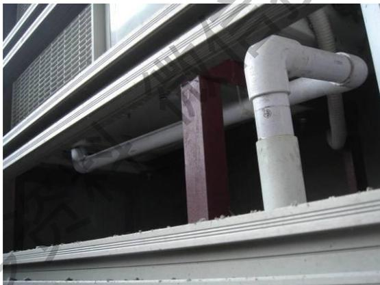
4.6.2. 室外机安装在平台基础上时应设置排水沟。
