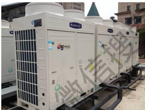
9.1.2. 室外机若安装在自然通风无法满足机组换热要求的位置时，应选择带静压的室外机组，并接导风管排风或外加风机强制排风。
