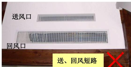
7.1.5. 金属、金属喷塑、烤漆风口的安装，风口与风管的连接应严密、牢固；边框与建筑装饰面贴实，外表面应平整不变形，调节应灵活。风口水平安装，水平度的偏差不应大于 $3/1000$ ；风口垂直安装，垂直度的偏差不应大于 $2/1000$ 。
