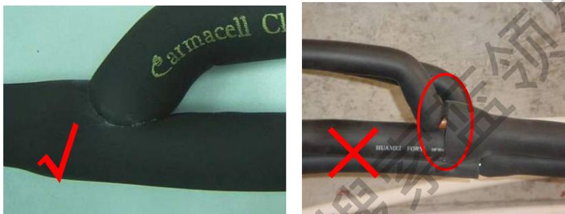
5) 铜管与室内机连接处必须保温严密。
