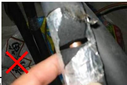
4) 分歧管保温结合处必须连接紧密，禁止出现缝隙。
