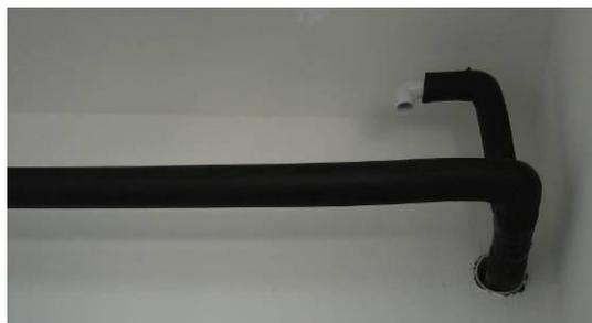
7) 管道穿越墙体或楼板处应设钢制套管，套管较排水管大2个规格，且管道接口不得置于套管内。
