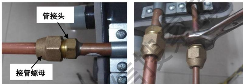
2) 然后使用另一把匹配的固定开口扳手或活动扳手卡紧接管螺母，注意不要有间隙，避免打滑；
