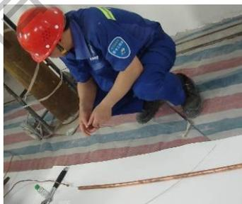
3.4.4. 配管前应穿好保温管，穿保温管时，铜管端口必须用胶布缠好封口，避免杂质进入。
