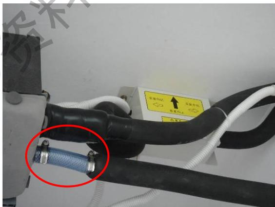
1) 与室内机的接管必须为软管，软管为透明或半透明管，可以观察到冷凝水排水状况，排水软管不得有瘪管或强扭现象；
