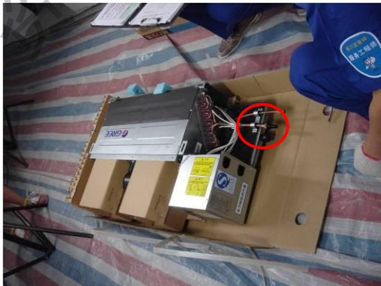
2.2.4. 手动拨动电机风叶，确认风叶转动是否正常；条件许可的情况下，接线控器和调试器通电检测室内机的电机运行是否正常。
