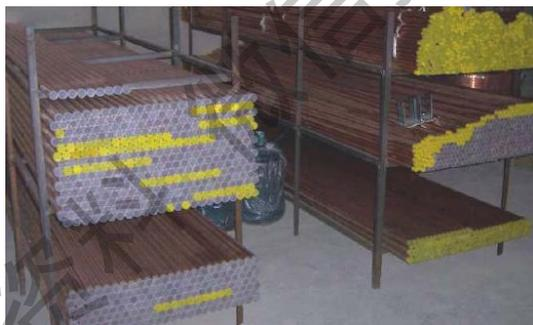
3.2.3. 施工过程中的管端部也必须做好保护。根据加工部位、工期及周围环境、最有效的方法是夹扁焊接封口和缠胶带封口。
