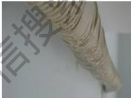
10. 导风板几乎处于关闭状态，导风板凝露水很多。
