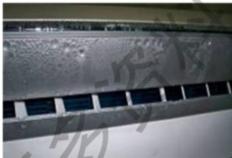
16. 接水盘里、挡水板上结满污泥、灰尘。
