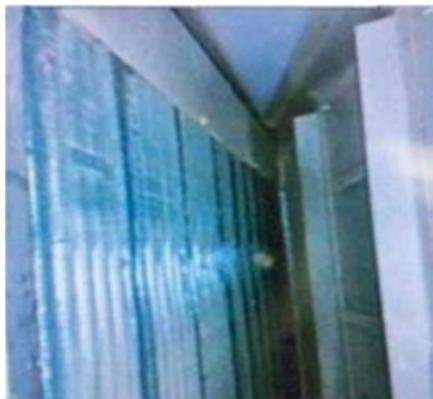
18. 系统泄漏后，蒸发器结霜、结冰。
