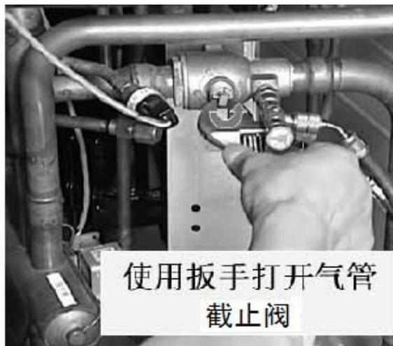
【注】均油截止阀也用内六角扳手打开，均油截止阀打开用的内六角扳手比液管截止阀小一个规格。
