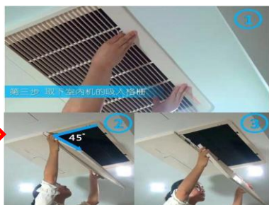
两手按钮向前按压并往下拉吸入格栅。当吸入格栅与面板呈45°夹角时，将吸入格栅上提即可取下。
