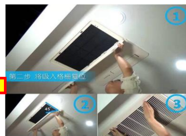
吸入格栅与面板呈45°夹角，使得吸入格栅能与连接部位相连。推动两个按钮，将吸入格栅复位。
