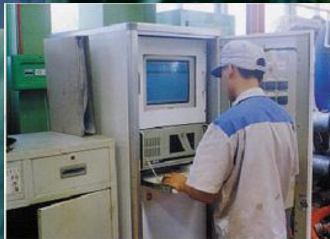
出厂前综合检测
